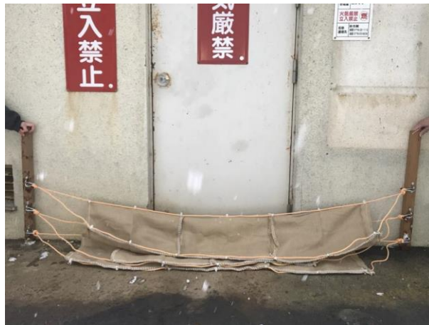
図13 吸水式水囊の使用方法
